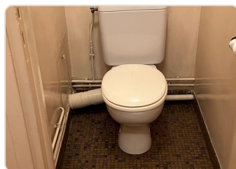
WC : sol mosaïque et tuyaux ; le cumulus ira en hauteur au fond, au-dessus de l'étagère
