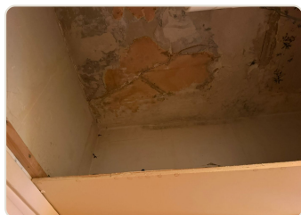
Au-dessus du faux plafond : murs bruts
